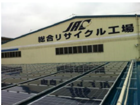
【図表 26】太陽光発電設備
