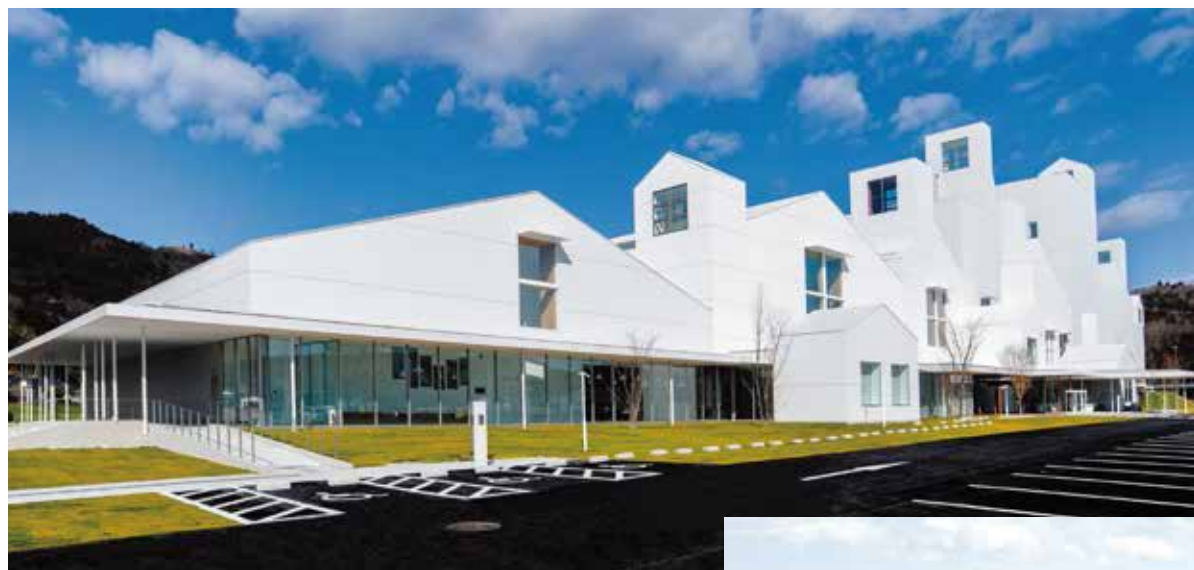
石巻市複合文化施設 マルホンまきあーとテラス
