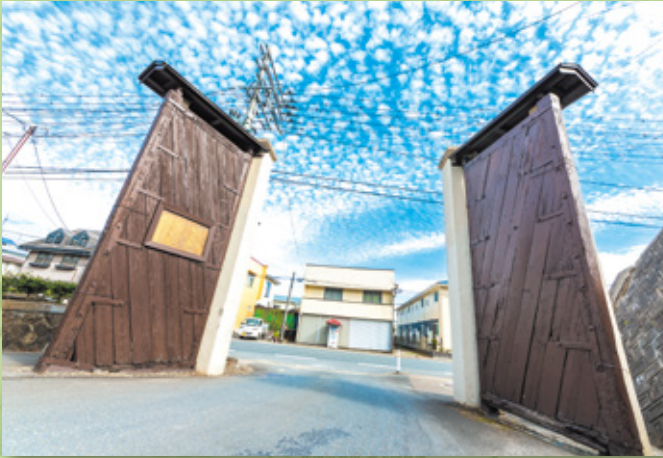
鹿島台小学校の校門の一部として残されている、 鳴瀬川の水を逆流させないために使用された小川開門
