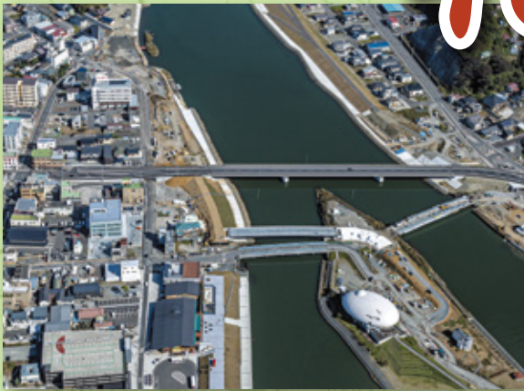
令和2年9月10日 新内海橋開通 撮影：令和2年10月21日
