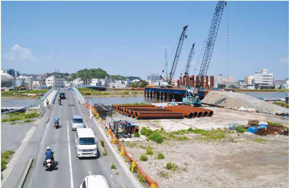
復興に向けて架け替え工事が進む、市内の橋
