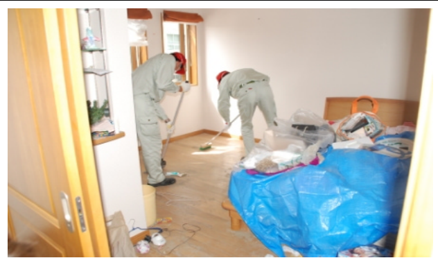
石巻市内の津波被害宅 2 階清掃
