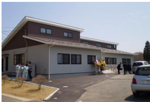
・施設外観の様子
